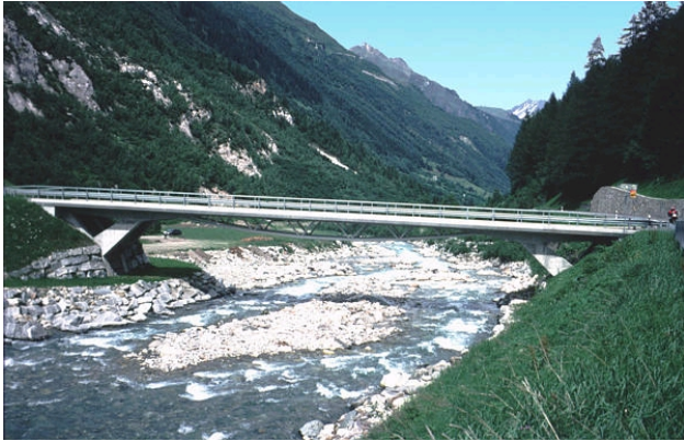
Figure 9 : Pont sur le Tessin à Villa Bedretto, longueur 44.00 m
