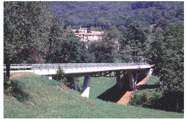
Figure 7 : Pont sur le Capriasca à Odogno TI, longueur 68.50 m, portée centrale 38.00 m
