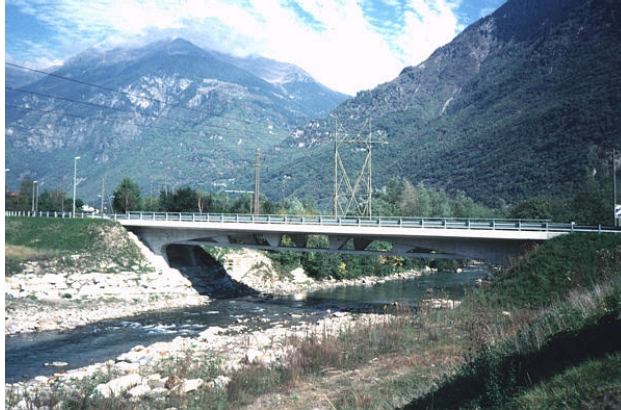
Figures 5 et 6 : Pont sur le Brenno à Loderio en béton armé précontraint, longueur 48 m
