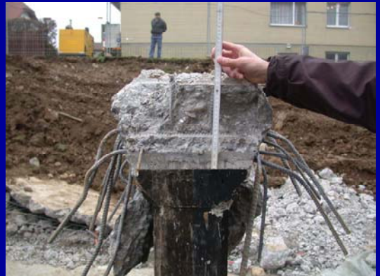
Stützenkopf der Stütze E3
