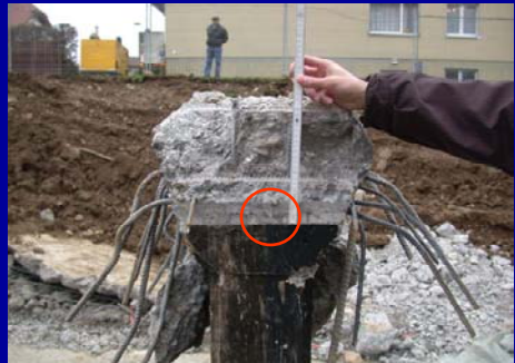
Bohrkernentnahme aus dem Stützenkopf
