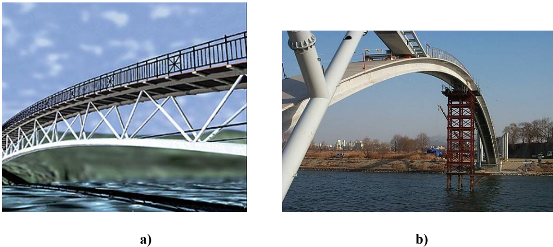
Figure 10: Applications des bétons à ultra haute performance : a) passerelle cyclo-pédestre à Sherbrooke et b) passerelle de Séoul
