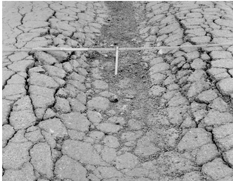
2-16 Poinçonnement d'une route lors du dégel (hiver 1962-63)
