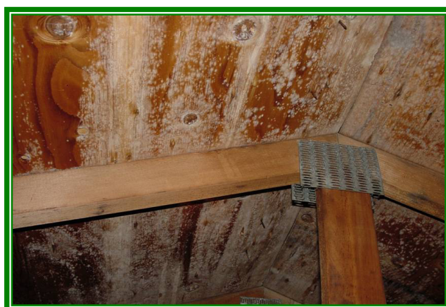
Photo 2 : Dégâts provoqués sur la charpente en bois par Aspergillus niger
