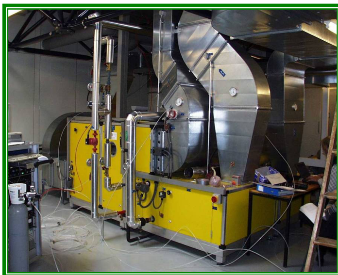
Photo 1 : Vue extérieure d'un système de ventilation d'une salle de cours à l'EPFL.
