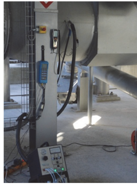
Figure 6-3 : Instruments utilisés pour les mesures d'émissions en centrale d'enrobage
