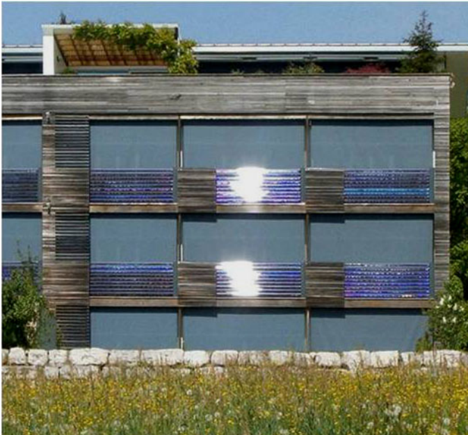
Capteurs intégrés en façade (Sunny Woods, arch. Beat Kämpfen)
