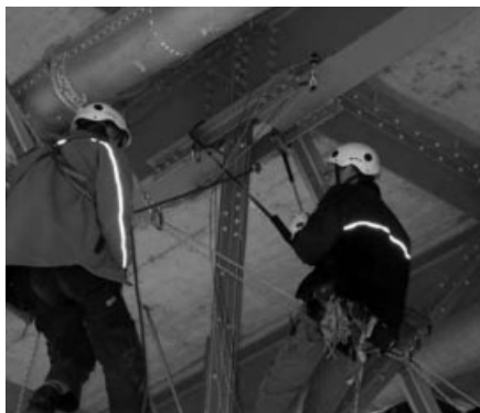
Bild 5. Bergführer während des Anbringens der Reibungsmessstreifen am Querträger
