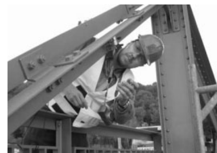
Bild 8. Anbringen der Reibungsmessstreifen an einer Bogendiagonale
