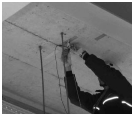
Bild 6. Anbringen eines Reibungsmessstreifens an der Unterseite der Betonplatte
